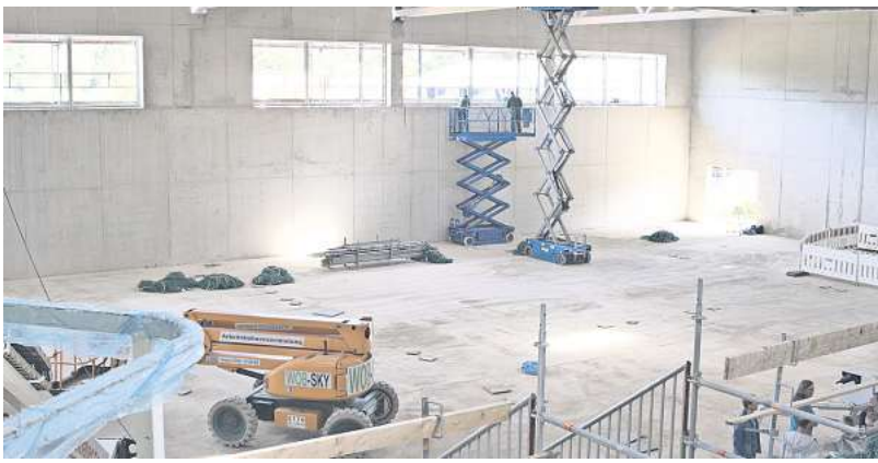
Rohbau: Bis zu 400 Zuschauerinnen und Zuschauer haben zukünftig auf der erweiterbaren Tribüne Platz.
