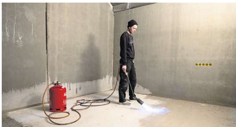
Arbeiter trocknen derzeit die Räume im Untergeschoß mit dem Brenner.
